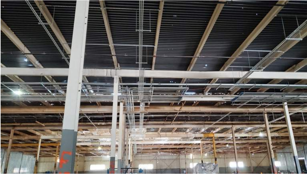
New overhead electrical conduits
